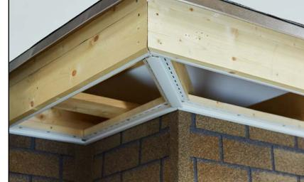
**3.3.** Для углового соединения панелей используется H-профиль.
