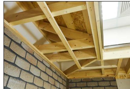
**1.2.** На бруски смонтировать обрешетку. В качестве обрешетки рекомендуется использовать доску 100 × 25 мм. По краям свеса монтируется направляющий профиль (J-профиль).
