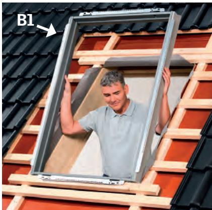
Комплект для гидро- и теплоизоляции для еще более простой и надежной установки мансардного окна. Комплект BDX включает теплоизоляционный контур (B1) для утепления между окном и кровлей.
