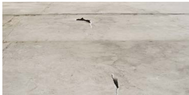
Последствия волочения тяжелых предметов.
